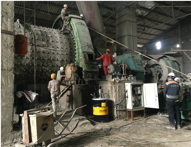
Lắp đặt hệ thống bôi trơn tự động cho vành răng hở Automatic lubrication system design and installation
