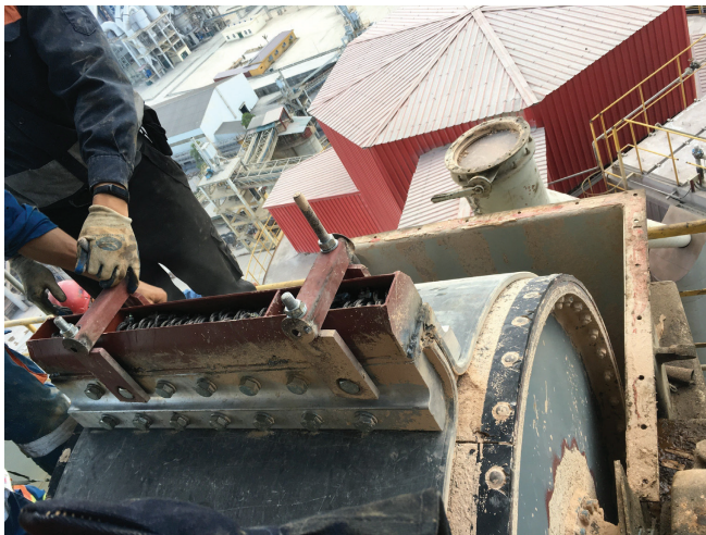
Giám sát lắp đặt thiết bị Aumund Supervising installation of Aumund equipment
