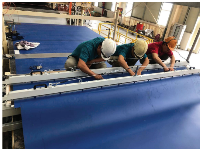
Lắp đặt dây đai, băng tải tại nhà máy gỗ MDF Belt installation at MDF factory
