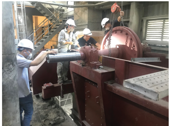
Cải tạo nâng cấp gầu xích Improving and upgrading bucket elevator of cement mill
