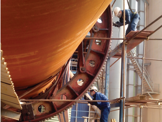
Dịch vụ mài sửa chữa vành răng hở Open gear repair grinding service
