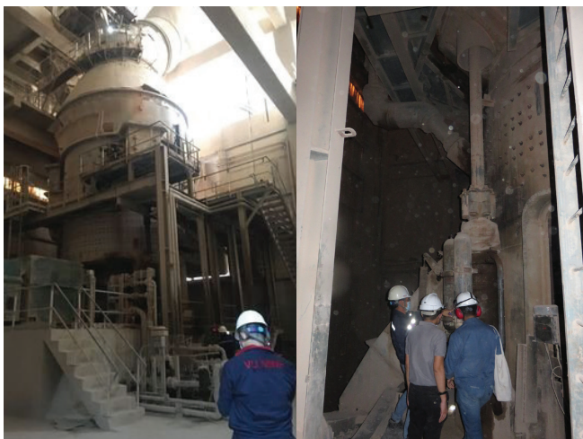
Khảo sát máy nghiền đứng Gebr. Pfeiffer Gebr. Pfeiffer vertical grinding machine inspection
