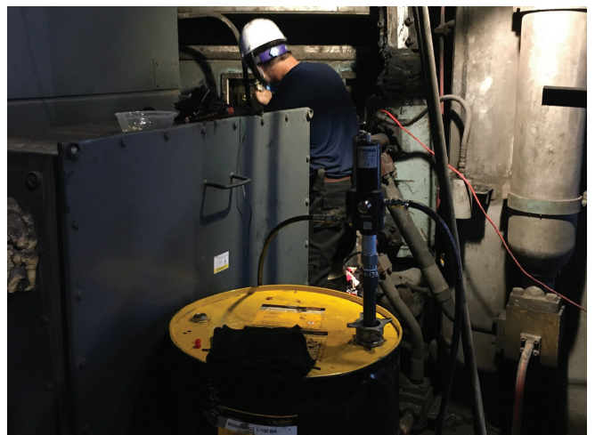
Thay dầu hộp số máy nghiền đứng Change oil for vertical mill gearbox
