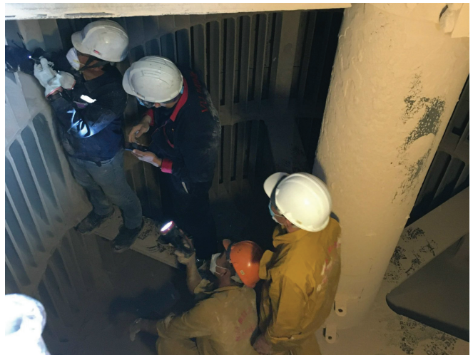
Đo khe hở cánh phân ly Gap measurement in vertical grinding machine
